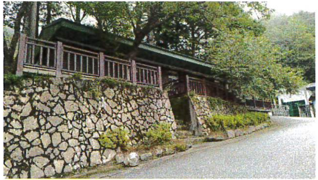
既有護管所內部空間調整及設施設備汰換
