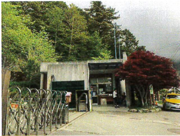
既有管制站空間增改建
