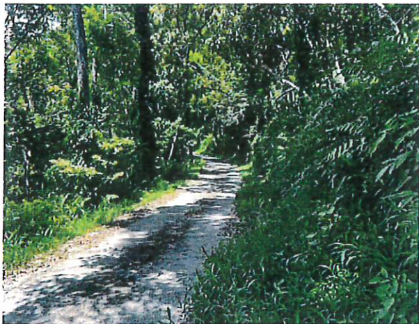
林道路寬狹小部分破損下陷掏空, 無橫向分流排水設施
